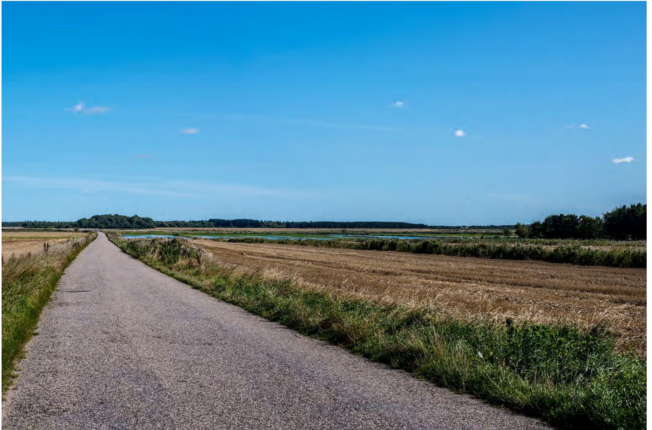
11: Lundbakvej, vest for Ryå EKSISTERENDE FORHOLD - Højre side af panorama
