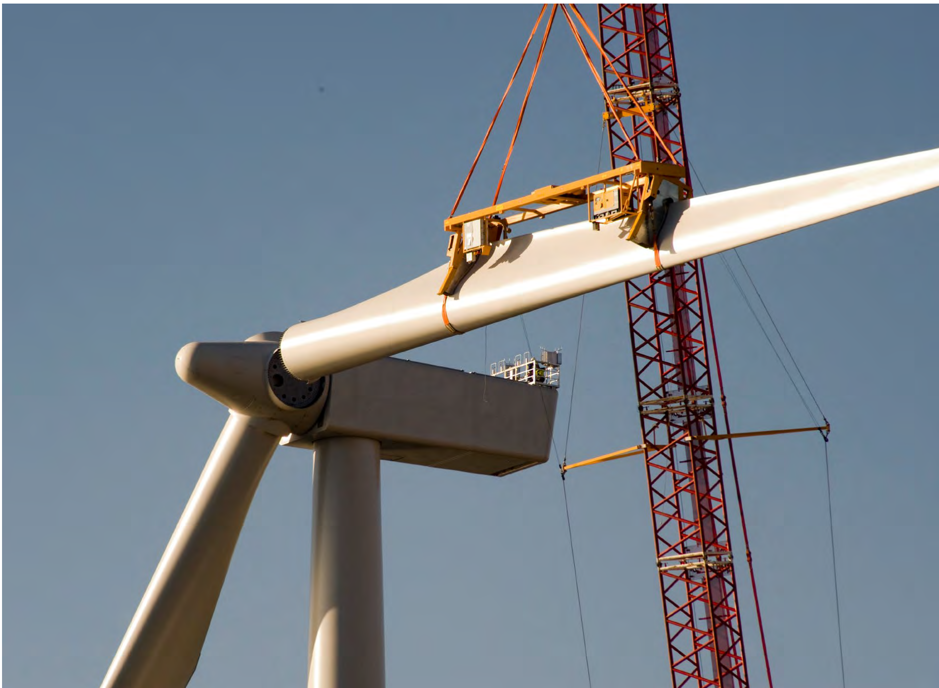
Montering af møllevinge er en del af kranarbejdet under rejsning af vindmøllen på stedet.
